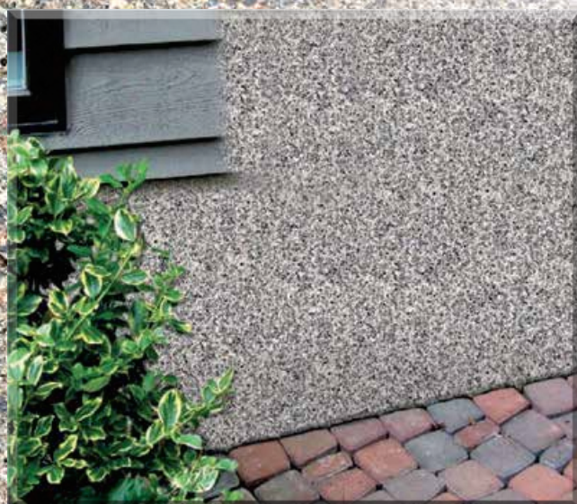
СТЕНЫ НА УЛИЦЕ
